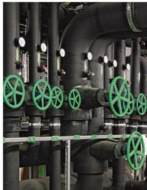
In diesen Rohren fließt Bodenseewasser, das zur Kühlung der Räume an der Universität Konstanz eingesetzt wird.
