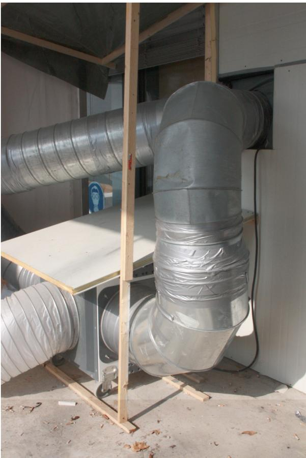
Bild 7: Von Asbest befreite Luft wird ausgeleitet.
