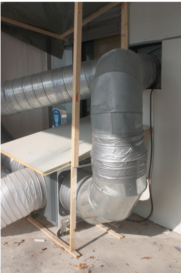
Bild 7: Von Asbest befreite Luft wird ausgeleitet.
