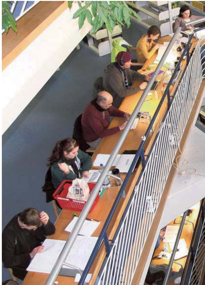
Drangvolle Enge: Im noch zugänglichen Teil der Konstanzer Uni-Bibliothek sind alle Arbeitsplätze belegt. Bis die Asbest-Probleme gelöst sind, könnten noch Monate vergehen. BILD: UNI
