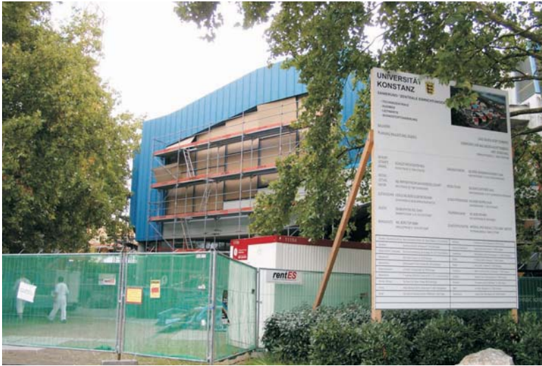
Bautafel Uni Haupteingang
