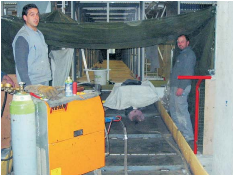
Zugang zum Erweiterungsbau
